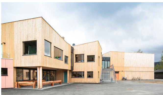
Sauland Skole Sauland, Noorwegen Educatie 1.700 m 2 2015 Bij PPAG Architekten
